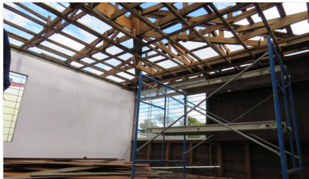
Imagen No 10. Demolición Casa Zapote (enero 2018).
