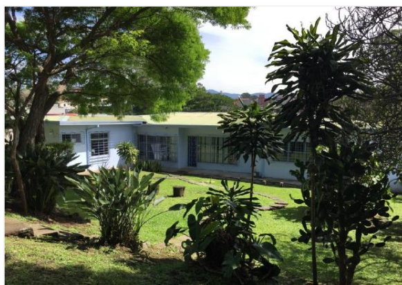
Imagen No 9. Construcción en el Terreno (Propiedad demolida).
